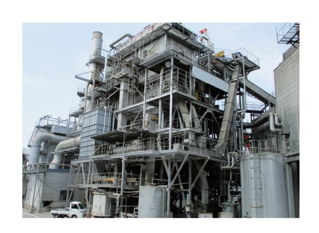
工場稼働の電気エネルギー75%と 熱エネルギーの95%を鶏糞発電 ボイラーで賄います。
